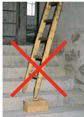
Sbagliato Da questa scala l'operaio fece una caduta mortale (ricostruzione).
