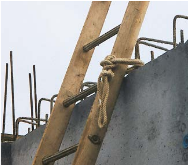
Fissaggio con legatura
