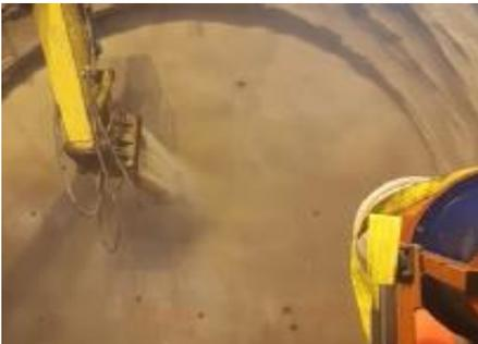
Figura 1 – Nebulizzazione fronte di scavo
